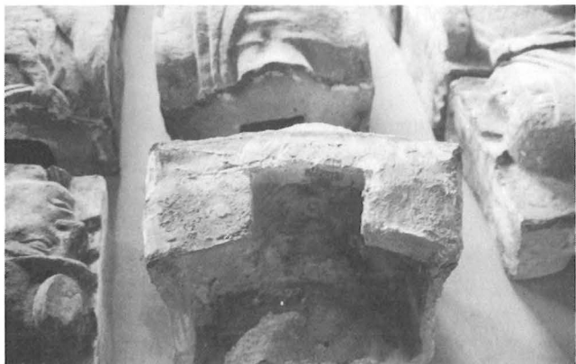
1. 裏側に付着していた建物の壁面部と目地のモルタルを削り取り、個々のブロックに分離。側面と中空の背面部。
