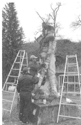
4.《採炭救国抗夫像(進発の像)》の応急処置作業
