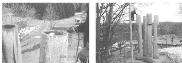
防腐剤塗布 2009年11月
