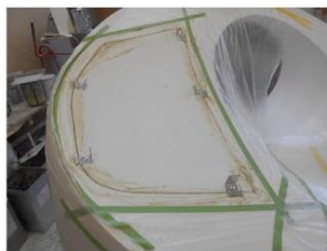
開口部仮固定、樹脂留め
