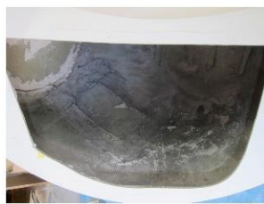
切断状況、内部状況確認（8月24日）
