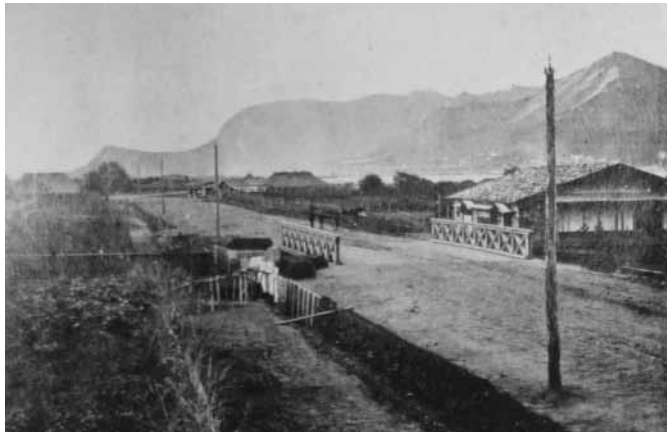
函館・亀田橋付近の電信線架設の様子（北海道大学附属図書館所蔵）
