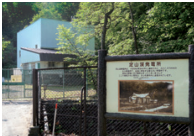
現在の定山溪発電所
