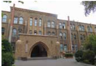
1929年に理学部本館として竣工した博物館。風格ある建物はそれだけで一見の価値がある
