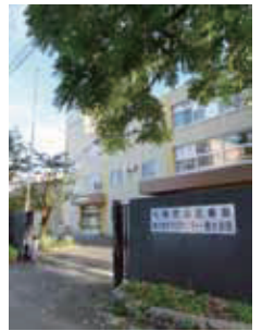
廃校した豊水小学校の校舎を活用した施設。建物内には豊水まちづくりセンター、豊水会館も設置されている。
