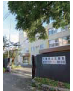
廃校した豊水小学校の校舎を活用した施設。建物内には豊水まちづくりセンター、豊水会館も設置されている。
